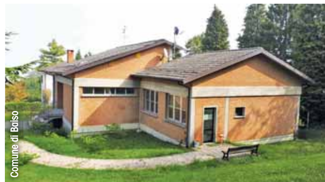
L'ex scuola elementare di Levizzano nel comune di Baiso (Re), oggetto dell'intervento per la realizzazione di una struttura polifunzionale socio-assistenziale
